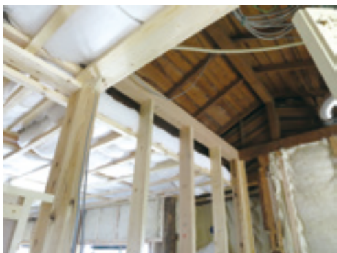
天井の断熱の施工例
