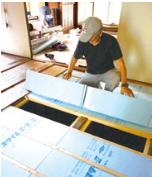
床断熱の施工例
